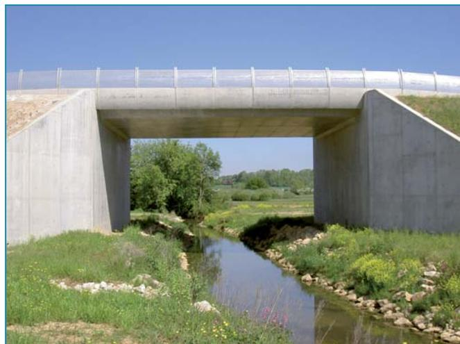
Figure 23 : Passage à faune inférieur sous la LGV Rhin-Rhône branche Est. Source : Petit A. 2011.
