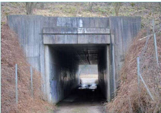
Franchissement inférieur sous la RN1019. Les dimensions sont réduites avec un important effet tunnel.
