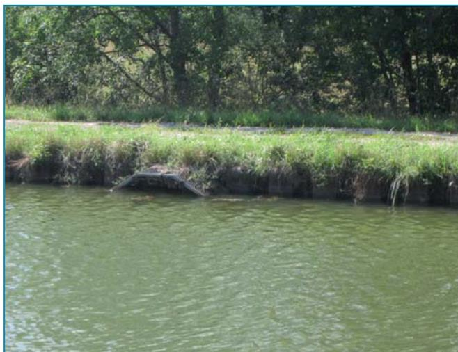
Figure 25 : Échelle à faune sur le Canal Rhin-Rhône. Source : AUTB, 2011
