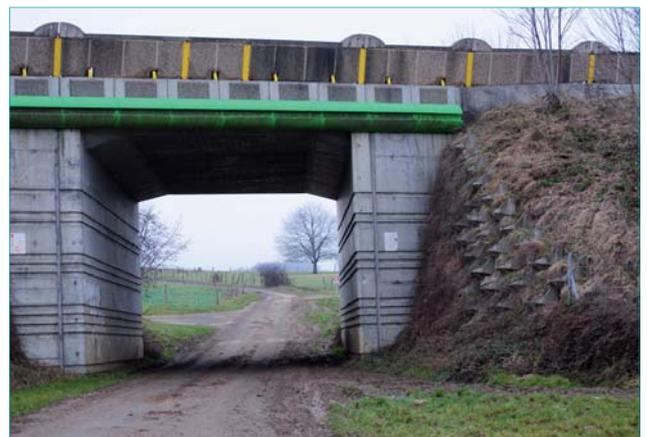
Franchissement agricole inférieur sous la RN1019, utilisable par la faune. Ses dimensions réduisent l'effet tunnel.
