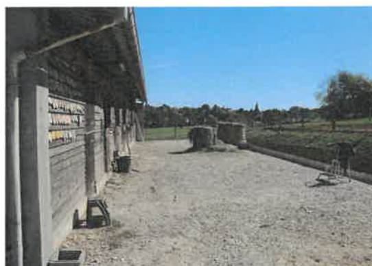
L'emprise du terrassement des futurs boxes
