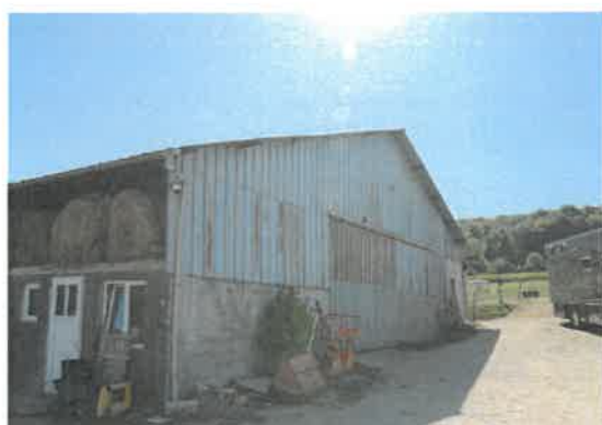
Le bâtiment agricole existant
