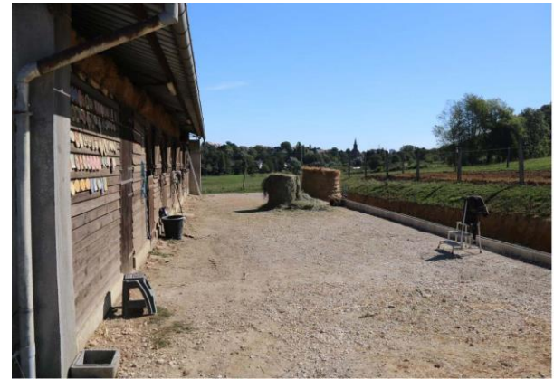
Emprise du terrassement des futurs box
