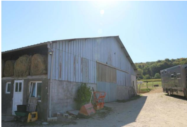
Bâtiment agricole existant
